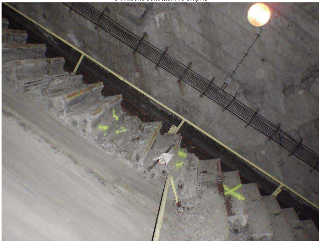
Porušené schodišťové stupně
