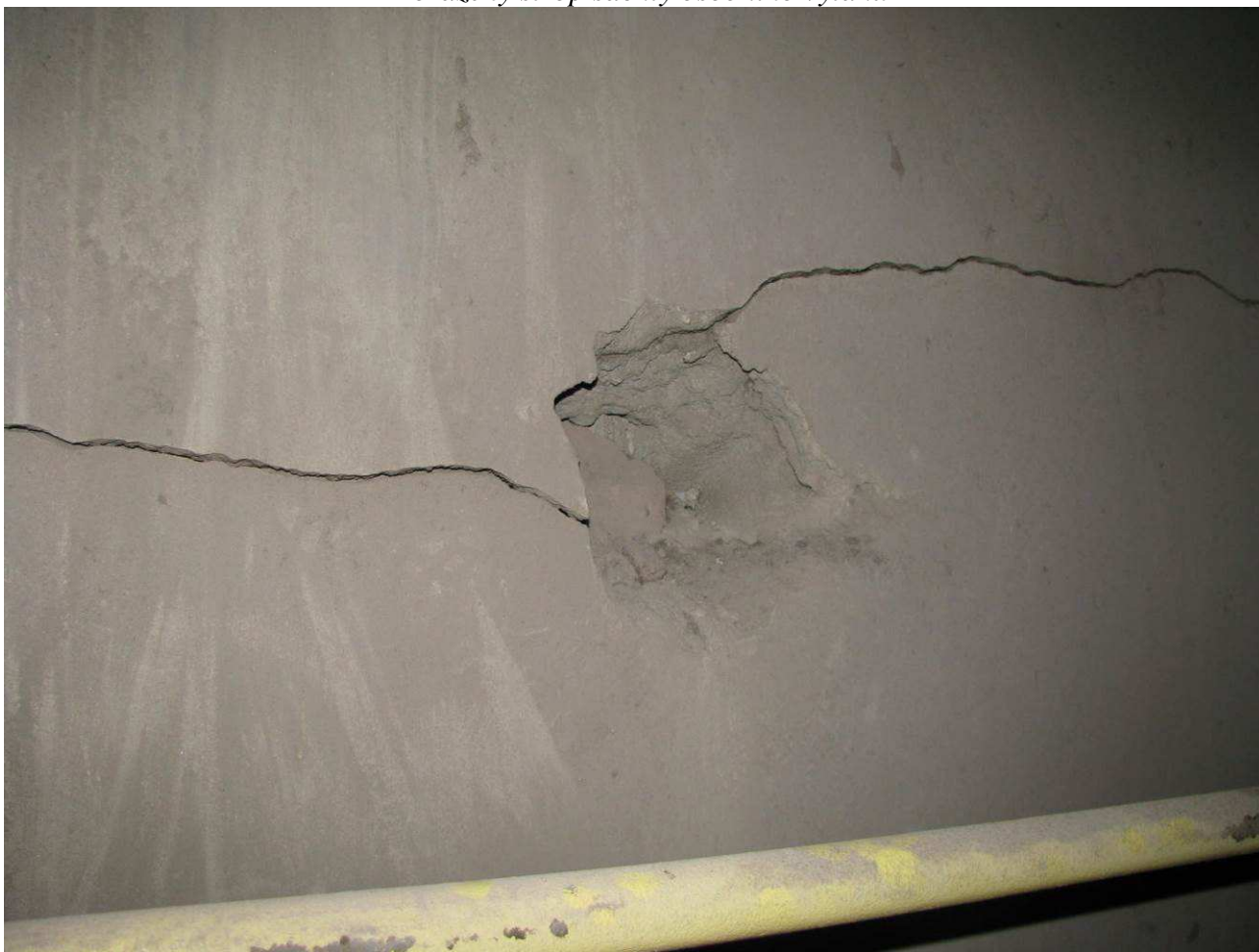
Proražený strop šachty osobního výtahu
